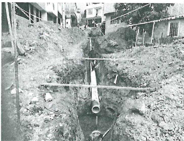
Alineación de la tubería en PVC Acanalada
