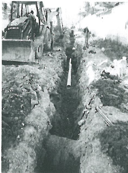
Excavación mecánica e instalación del colector principal
